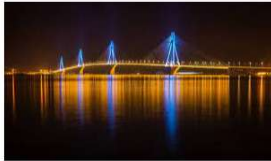
Γέφυρα Ρίο-Αντιρίου τη νύχτα, Ελλάδα Στοκ Εικόνα -... gr.dreamstime.com
